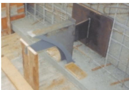
Posa in opera dell'ancoraggio della catena.
