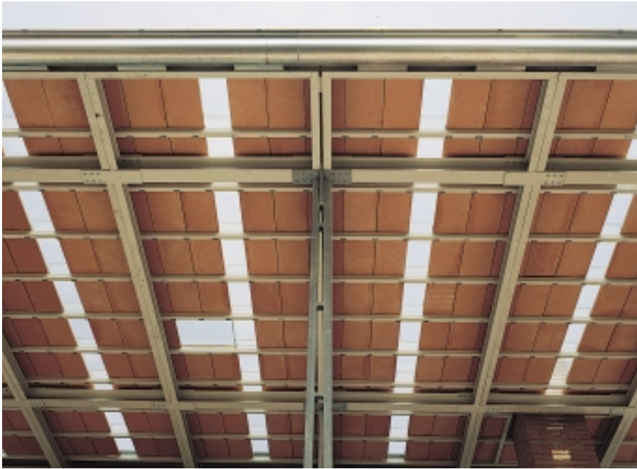
Vista dal basso della copertura con struttura metallica e manto in tavelloni di cotto e lastre di vetro.
