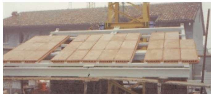
Prototipo del manto di copertura realizzato a pié d'opera.
