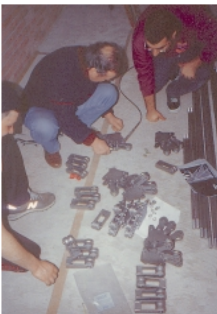
Montaggio del sistema di fissaggio della scala alla volta.
