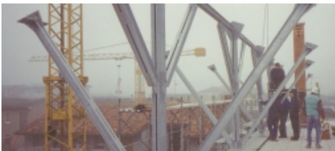
Vista del montaggio della struttura della copertura
