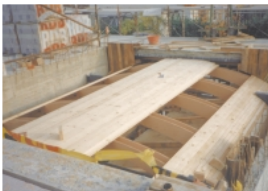
Montaggio della struttura provvisoria della volta.
