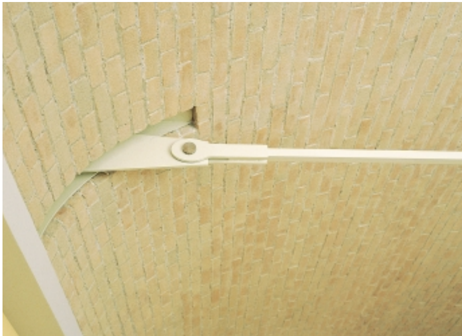
Dettaglio del fissaggio della catena alla volta.
