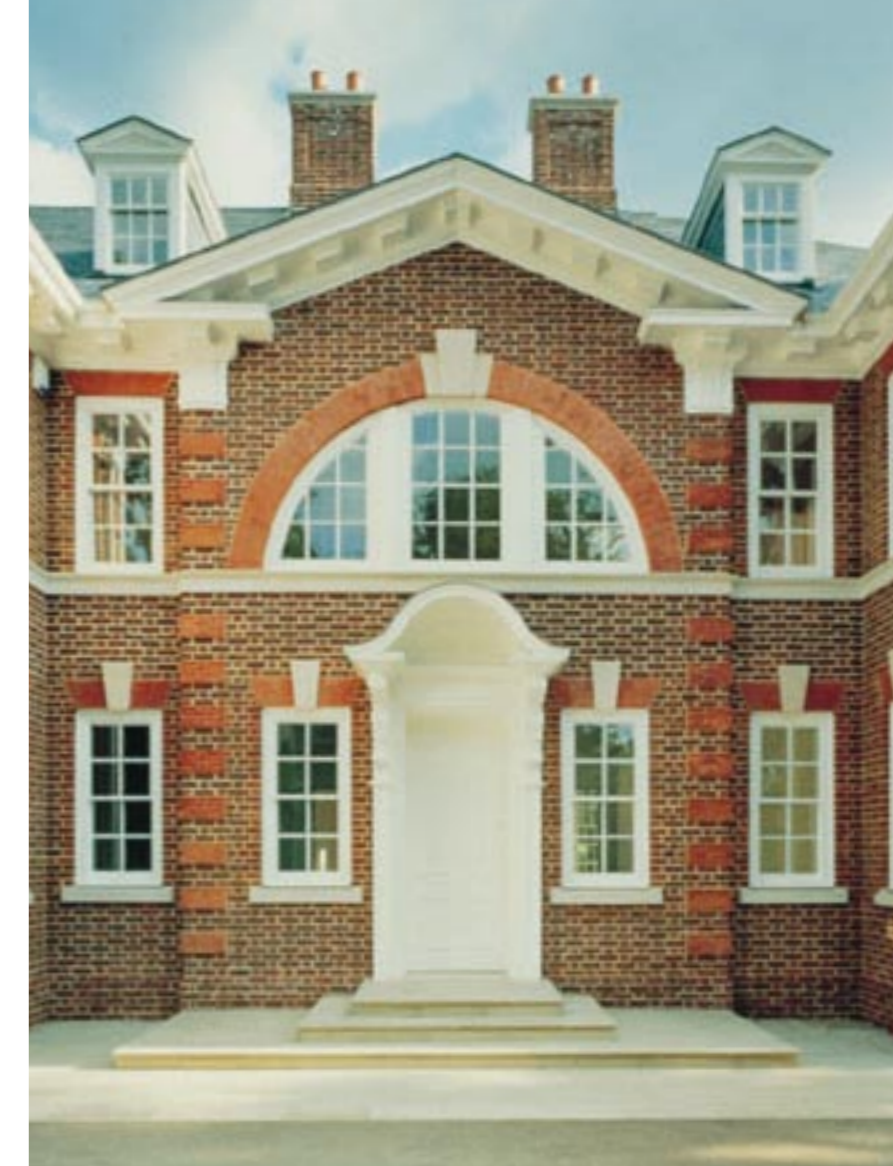
L'ingresso principale a nord.
