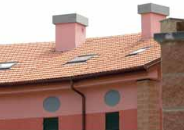
Particolare del tetto in laterizio.
