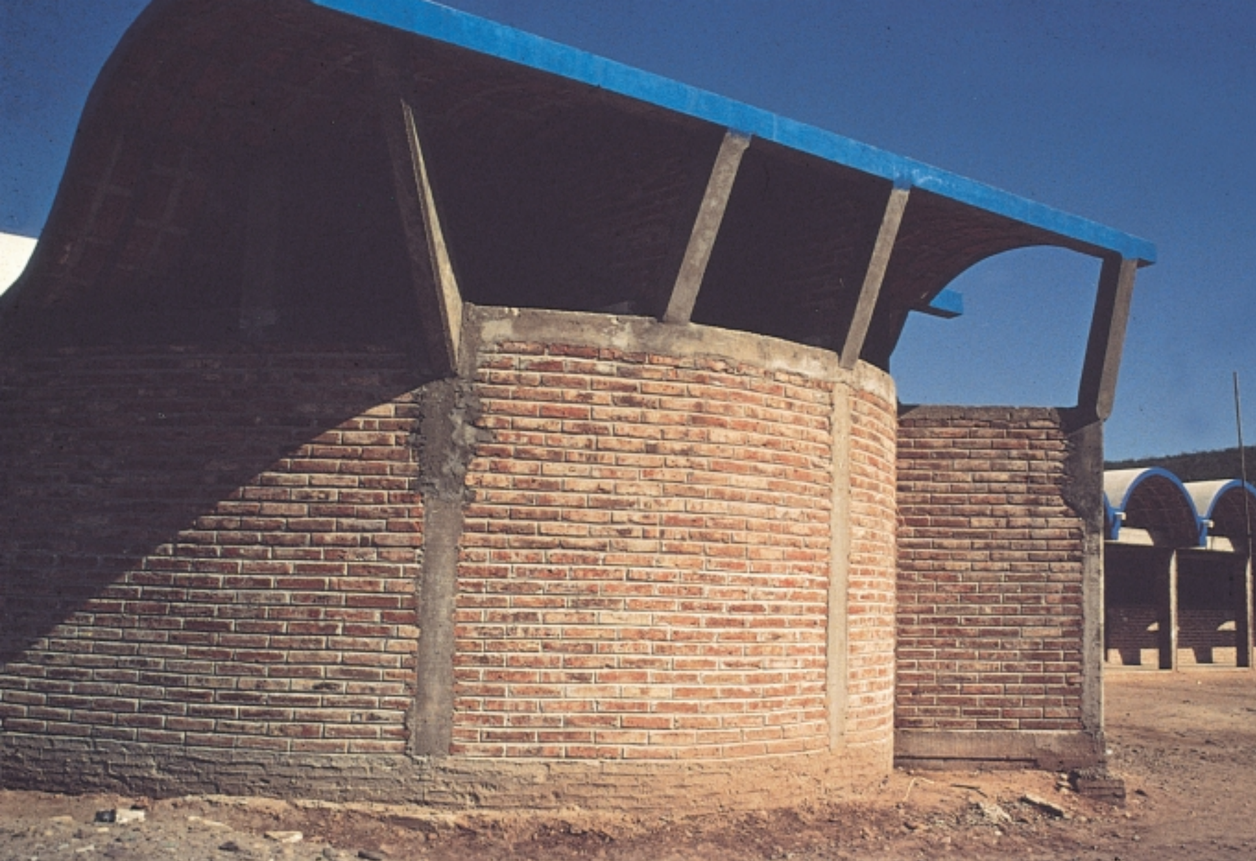
Scuola primaria di San Miguel Zapotitlán. Vista del corpo del bagno.
