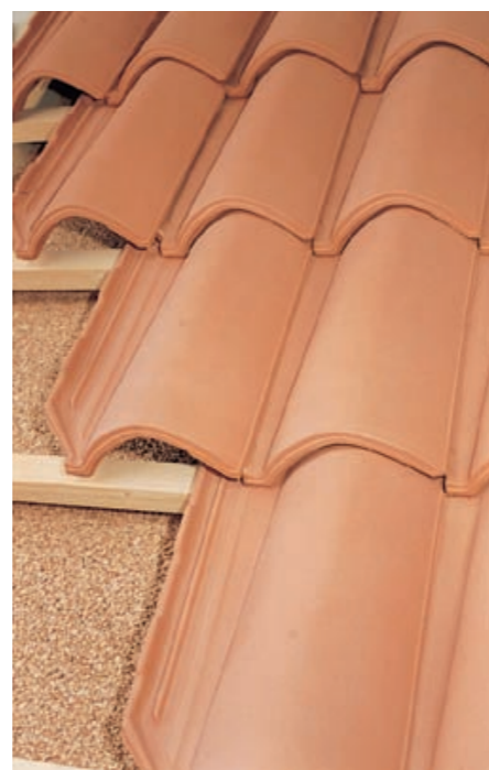
Particolare dell'assemblaggio degli elementi di tenuta (tegole in laterizio) sui listelli.
