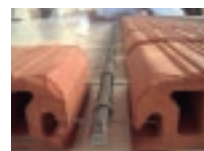
35. Alcune fasi del processo di semi-prefabbricazione.
