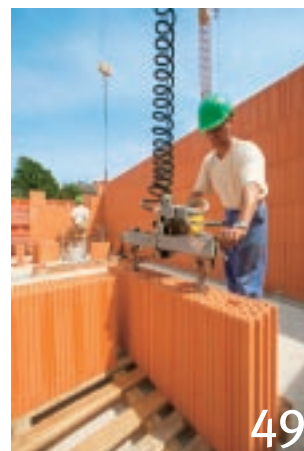
49. Blocchi rettificati di grandi dimensioni vengono sollevati e posati due a due mediante una speciale "pinza".
