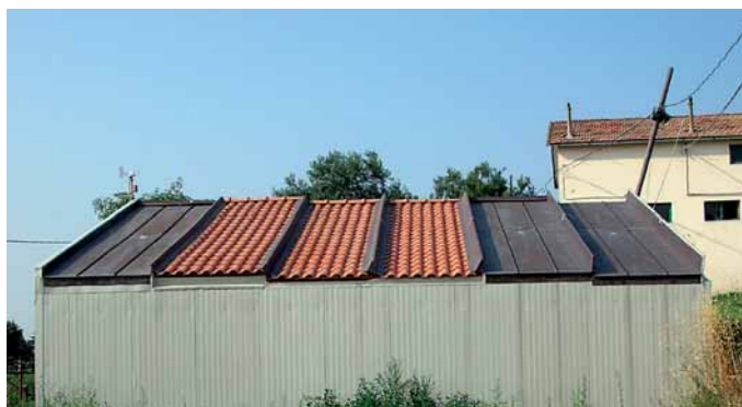
2. Edificio sperimentale con diversi sistemi di copertura fortemente isolati e diverso tipo di manto, oggetto di monitoraggio in fase estiva.
