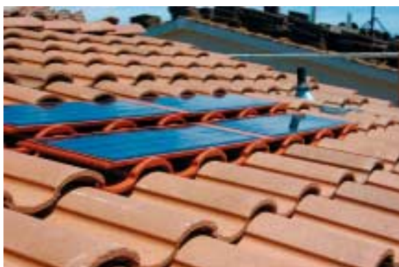
Fig. 8 - Sistema fotovoltaico ad integrazione con elementi plastici.
