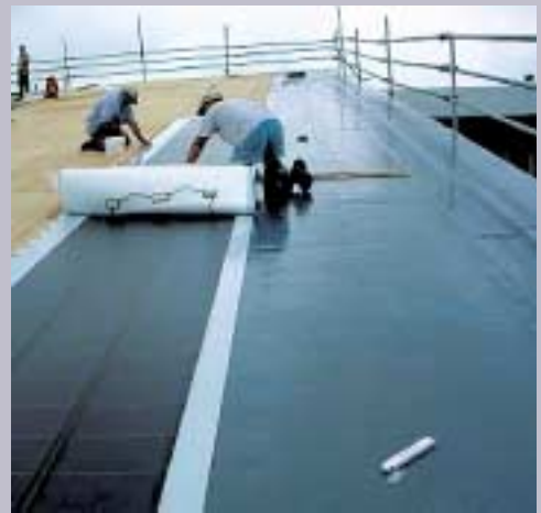
Fig. 4 - Guaina impermeabilizzante preaccoppiata con elementi fotovoltaici.
