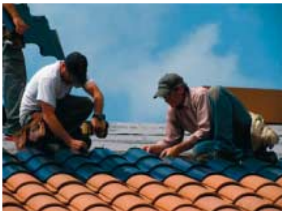
Fig. 9 - Sistema fotovoltaico a profilo curvilineo integrato.
